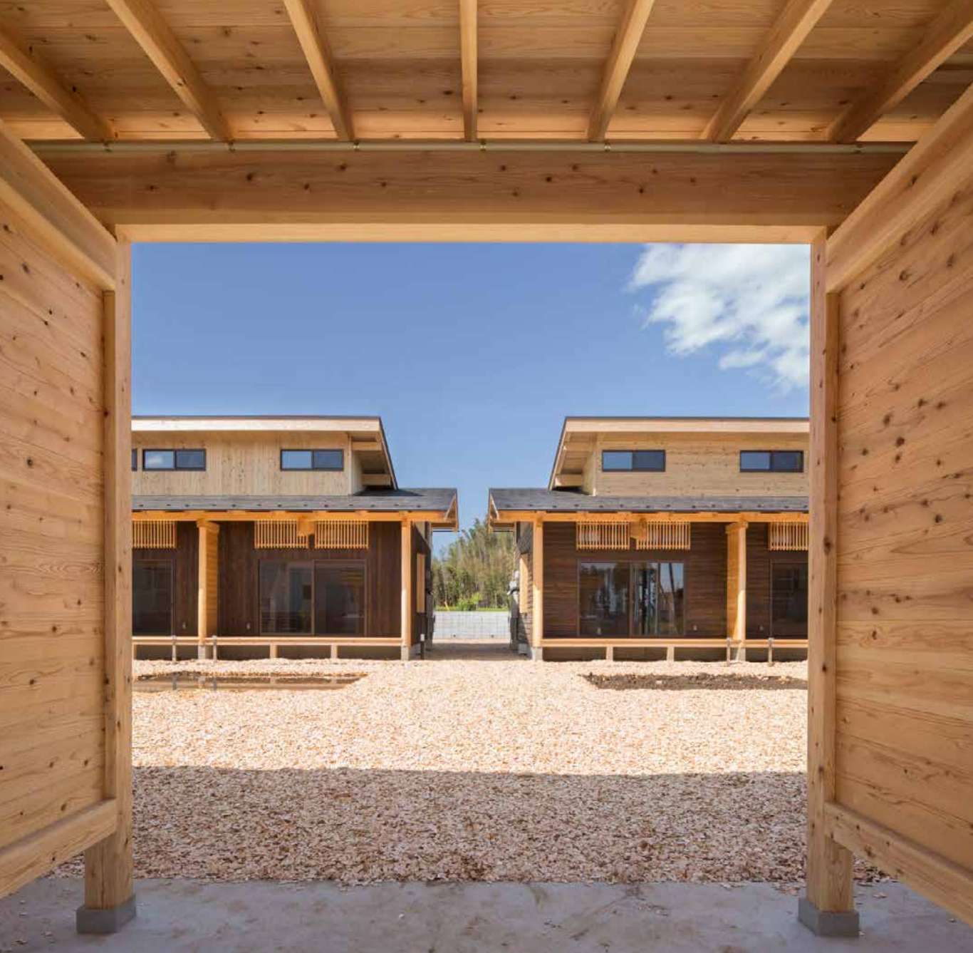
自転車小屋を兼ねた長屋門から2棟の長屋正面を望む。
