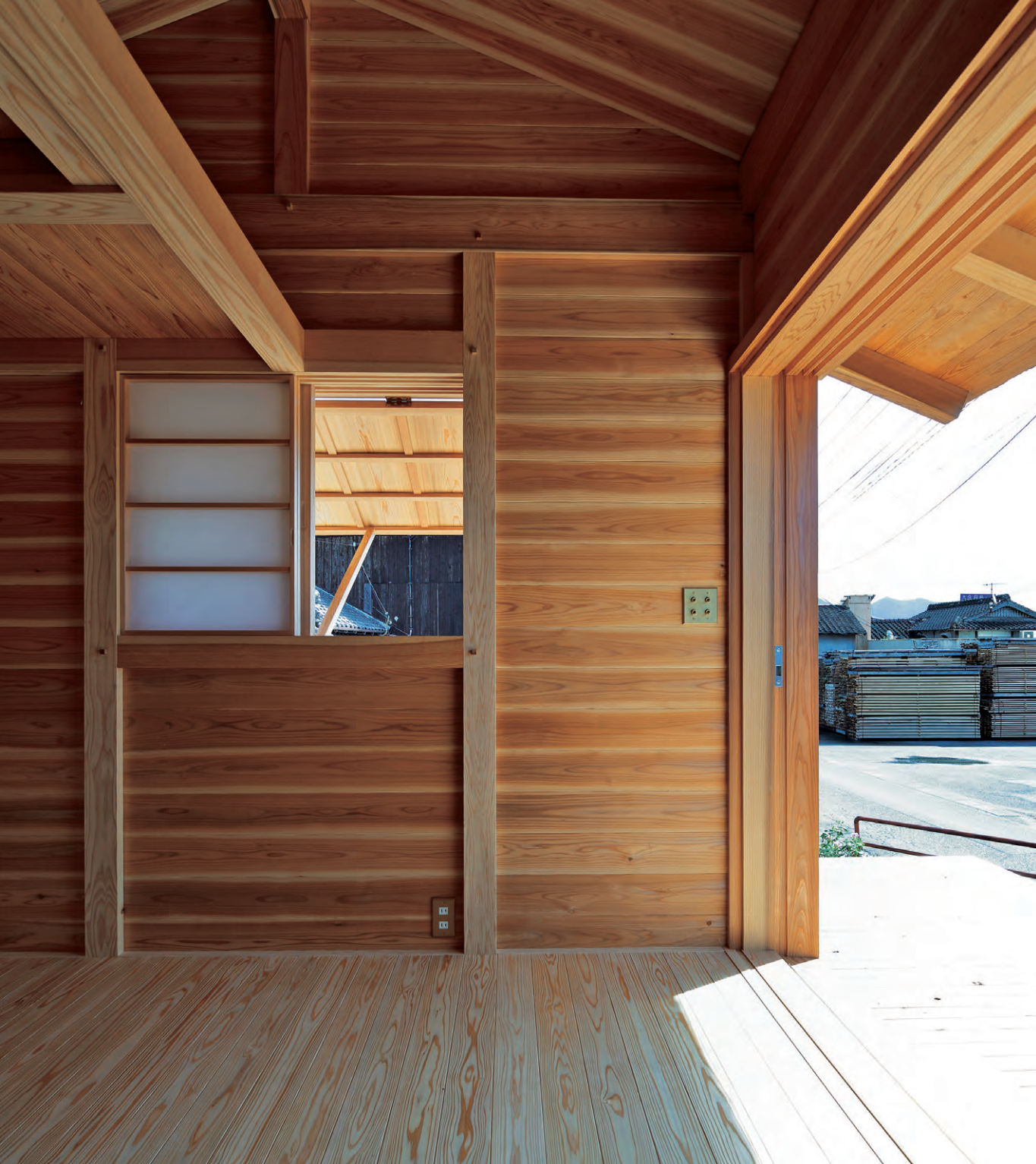
内部の柱は板目使い、壁板は源平材、床は白太の浮づくり。 ありふれた材料を活かす事例として見せている。
