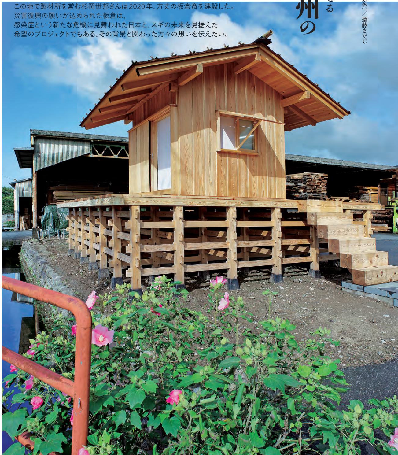
杉岡製材所の一角に建つ方丈板倉齋（さい）。災害の拠点、製材技術の展示、そして復興への願いと鎮魂という想いが込められている。
