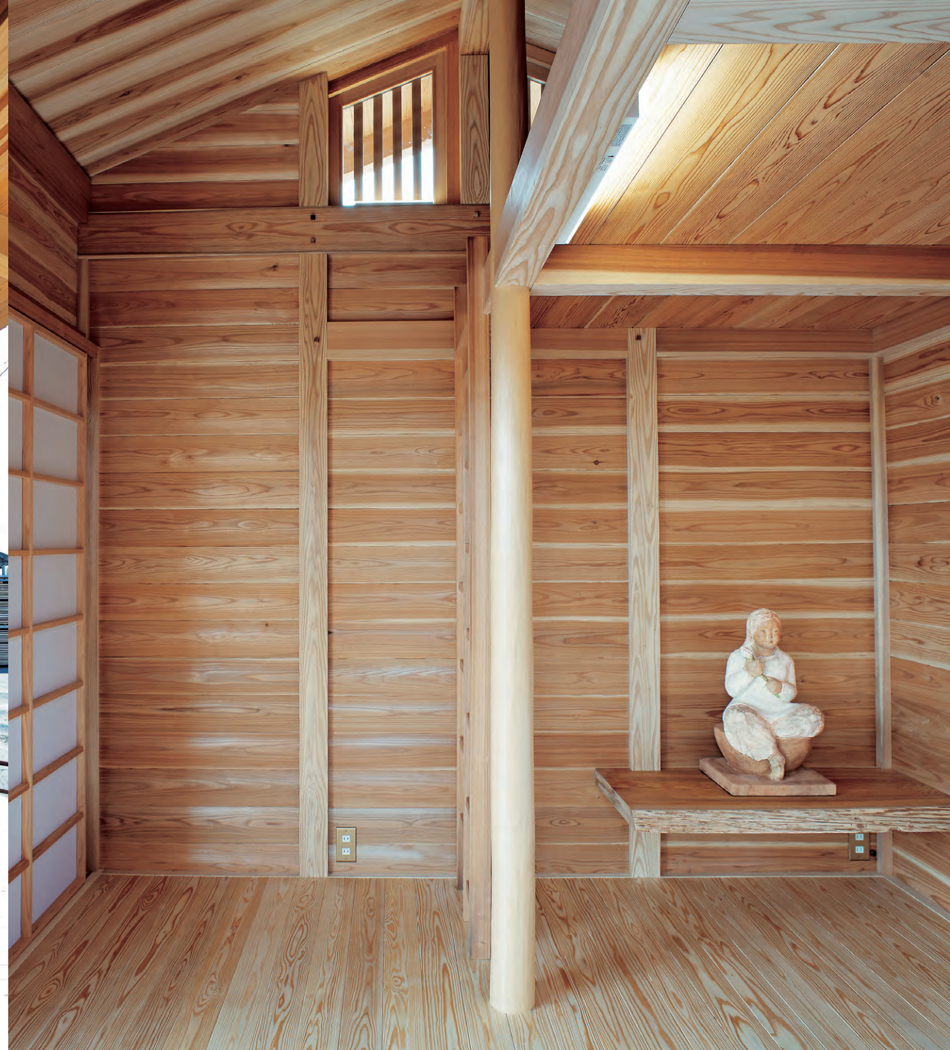
床には、拈華微笑の座像を安置。 高良杉の床板を宙に浮かせて前に座った人が座像の目線と合うように取り付けた。
