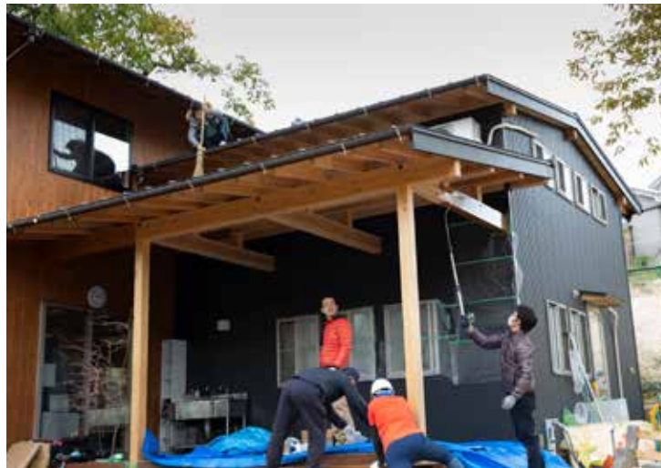
下／塗装や防蟻処理のホウ酸塗り、デッキづくりなど、保護者がDIYで参加した。町内会のようなコミュニティができています。左／下屋の梁に保護塗料を塗る金知聖さん。今回のプロジェクトで、保護者のリーダーを務めた。
