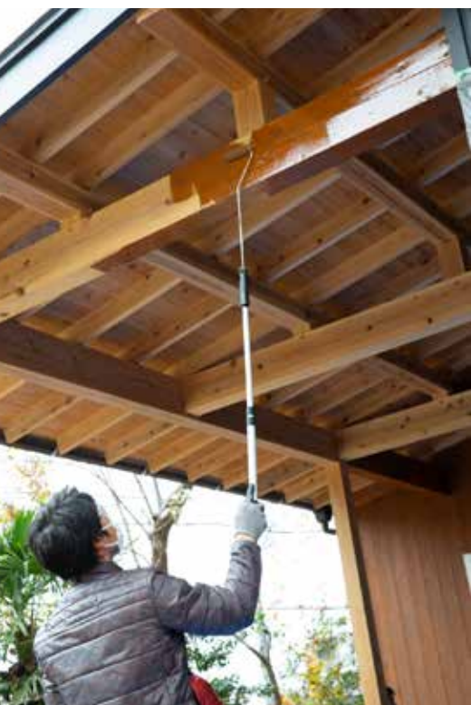
下／塗装や防蟻処理のホウ酸塗り、デッキづくりなど、保護者がDIYで参加した。町内会のようなコミュニティができています。左／下屋の梁に保護塗料を塗る金知聖さん。今回のプロジェクトで、保護者のリーダーを務めた。
